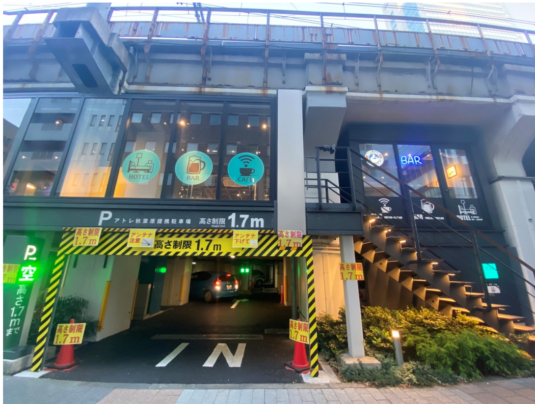
秋葉原-高架橋下空間
